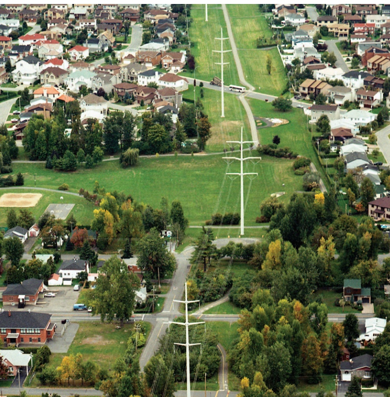
PHOTO : HYDRO QUÉBEC
